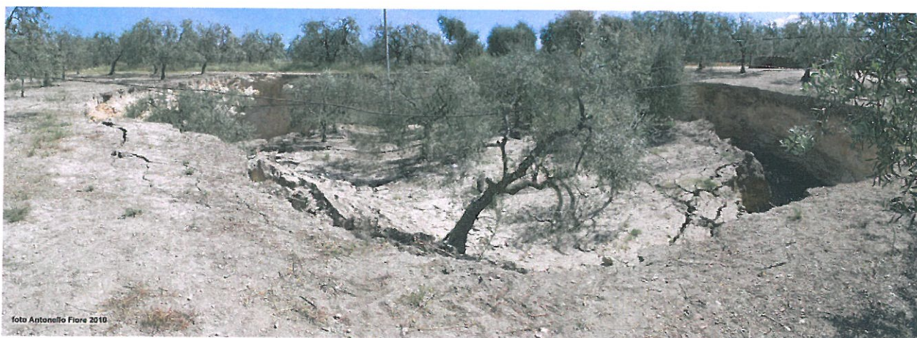
Barletta 2010 – Crollo di cave dismesse sotterranee in calacarenite
